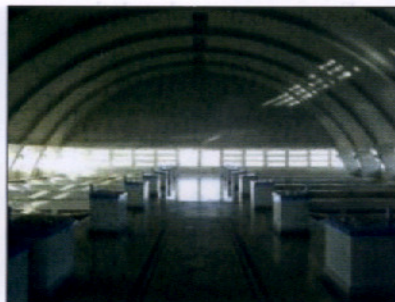
Figura 6. Vistas interiores ETAP Villa Azul, nave de filtración.
