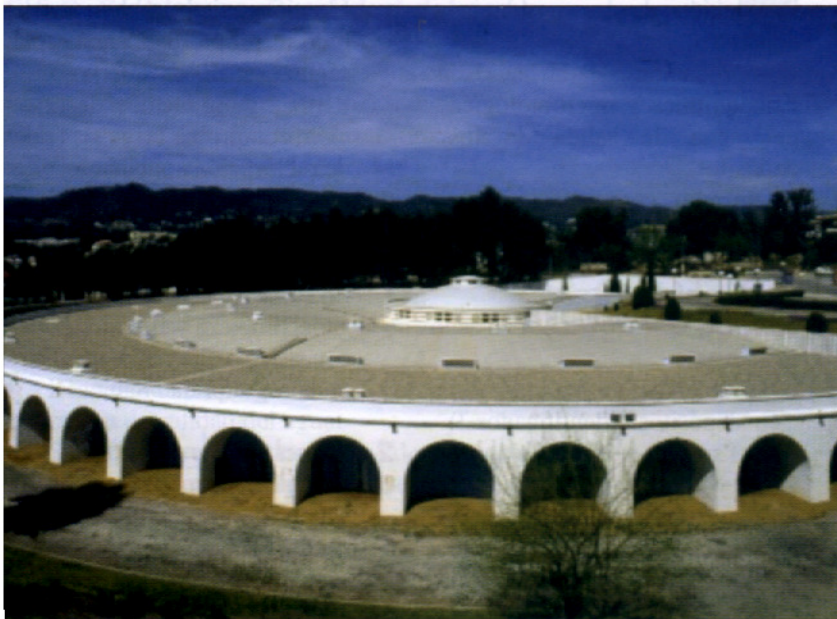
Figura 7. Depósito de agua de consumo de Emacsa.
