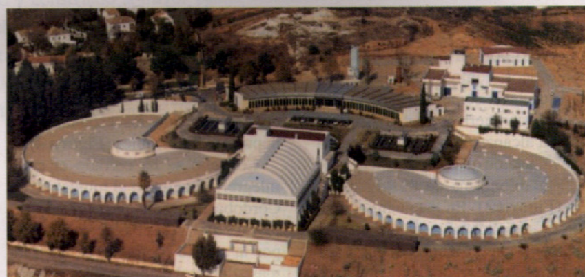
Figura 2. Vista general de la ETAP de Villa Azul.
