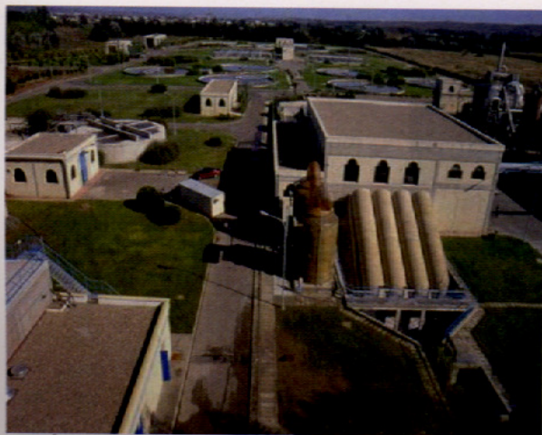
Figura 3. Vista general de la EDAR de La Golondrina.
