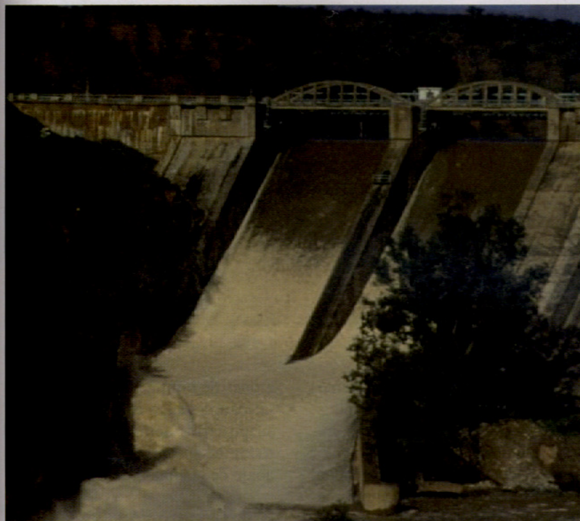
Figura 1. Presa del embalse de Guadalmellato.
