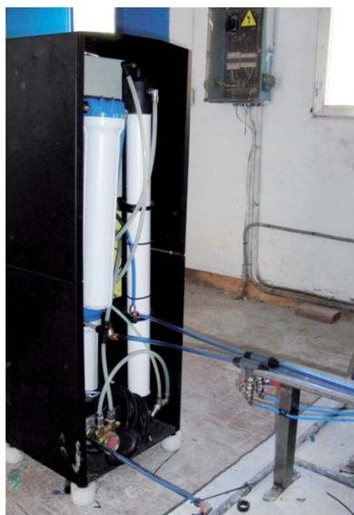
Vista posterior sistema nanofiltración: izqda. filtro carbón; dcha. membranas nanofiltración; abajo post-filtro.
