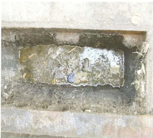
Figura 8. Aspecto de una alcantarilla típica
