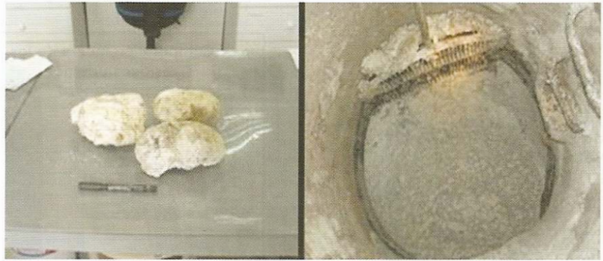
Figura 3. Izquierda: bolas de grasa; derecha: obstrucción de un colector con grasas+detergentes
