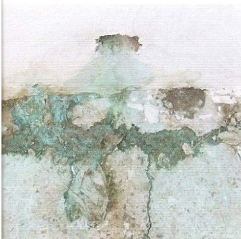
Figura 4. Efluentes con restos de pinturas
