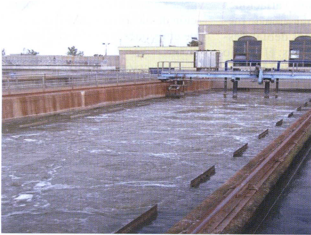
Figura 1. EDAR La Golondrina, desarenado-desengrasado.
