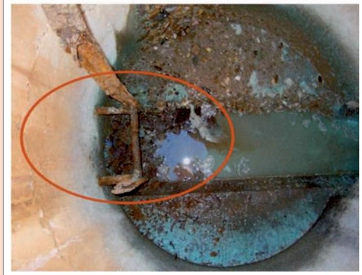
Figura 5. Agresión ácida sobre una acometida industrial de aguas residuales a un colector general de saneamiento (superior); (debajo) efectos de un vertido ácido sobre elementos de obra y metálicos en un pozo de registro.
