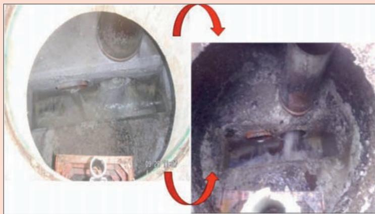
Figura 9. Alteración general de la arqueta de recogida de agua depurada en un tanque de oxidación total tras 3 años de servicio.
