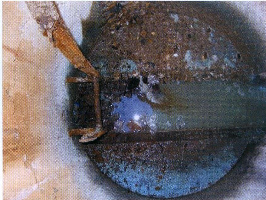
Figura 1. Corrosión provocada por vertidos ácidos.
