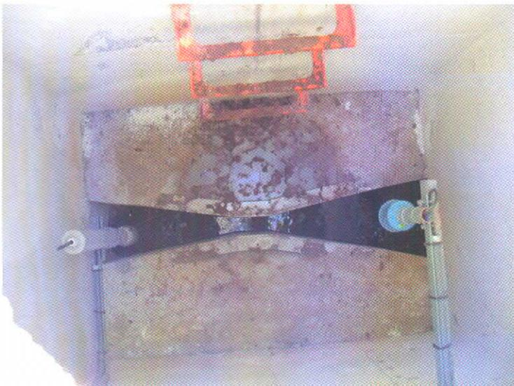
Medida on line de pH y caudal en salida de aguas residuales (parshall) de una instalación industrial
