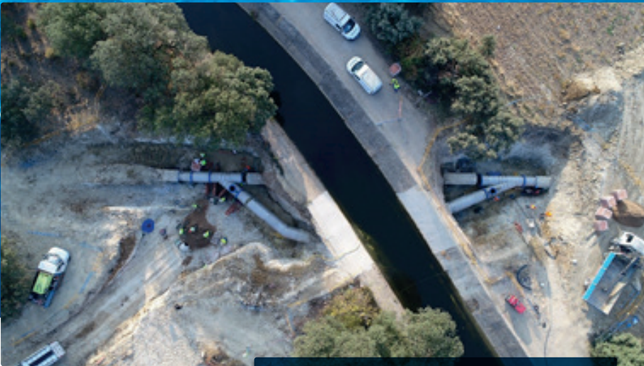
Área de reparación 2ª Conducción
