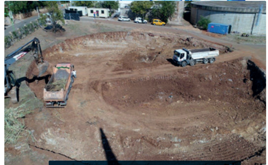
Construcción depósito carril Huerta de Arcos.
