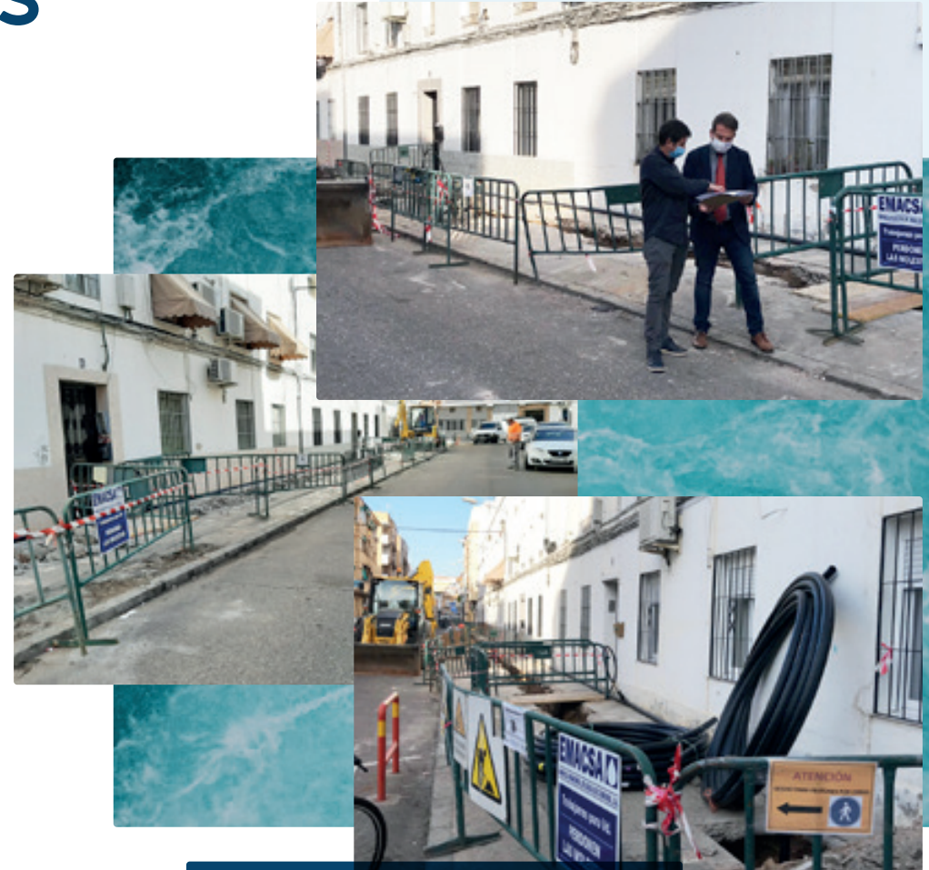
Obras Valdeolleros-Sancho el Craso.
