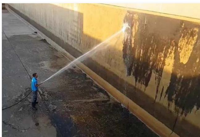
Fotografía 5: Limpieza mediante manguero de las acumulaciones algales en paredes interiores del DAB, tras un año de operativa.
