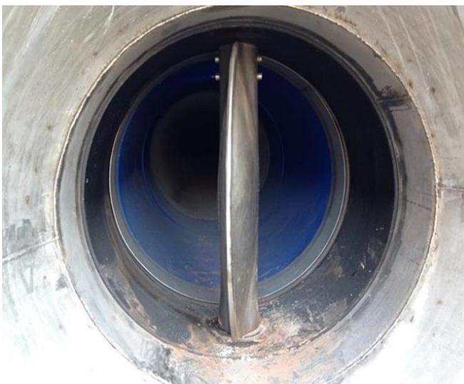
Fotografía 2: Válvula de entrada de agua al DAB (acero inoxidable AISI-316).
