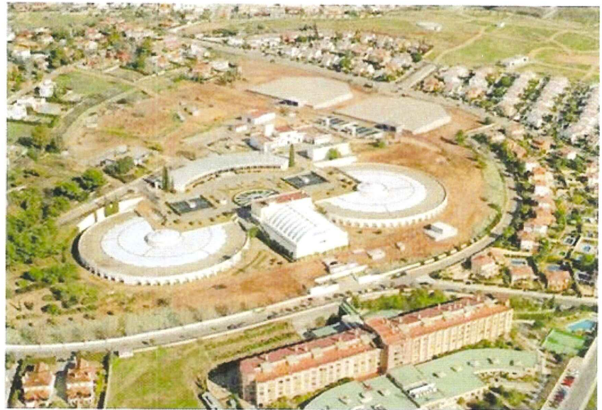
Fotografía 1. Imagen aérea ETAP Villa Azul (Córdoba)
