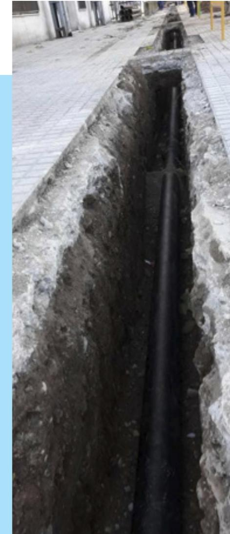
*Renovación de la red de abastecimiento en la Barriada de Levante. Fase1. Instalación de tubería en la Avda. Carlos III.*
