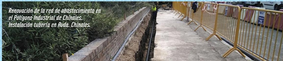
*Renovación de la red de abastecimiento en el Polígono Industrial de Chinales. Instalación tubería en Avda. Chinales.*
