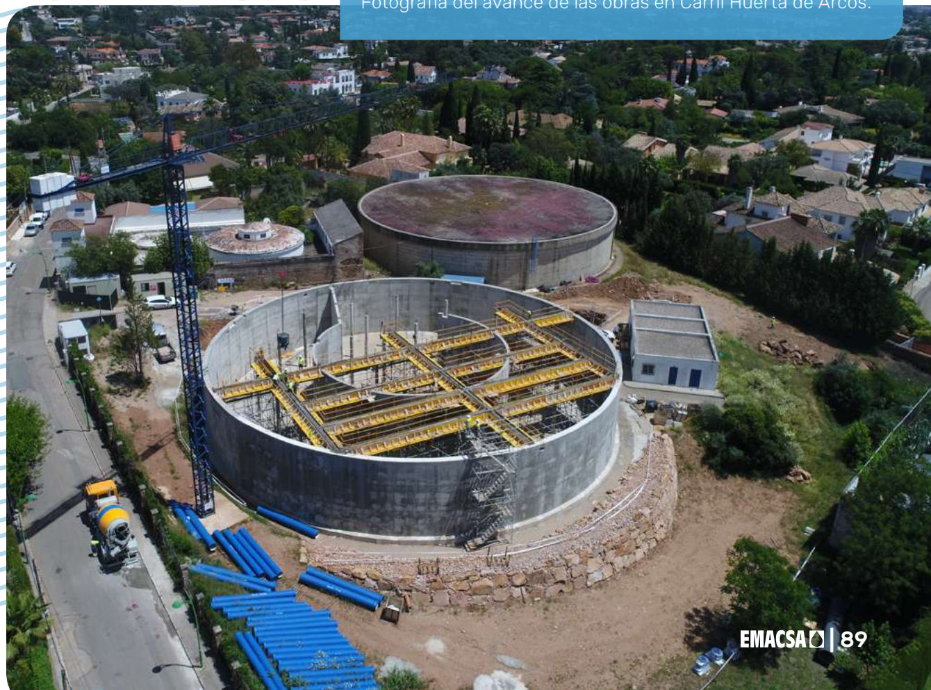
Fotografía del avance de las obras en Carril Huerta de Arcos.
